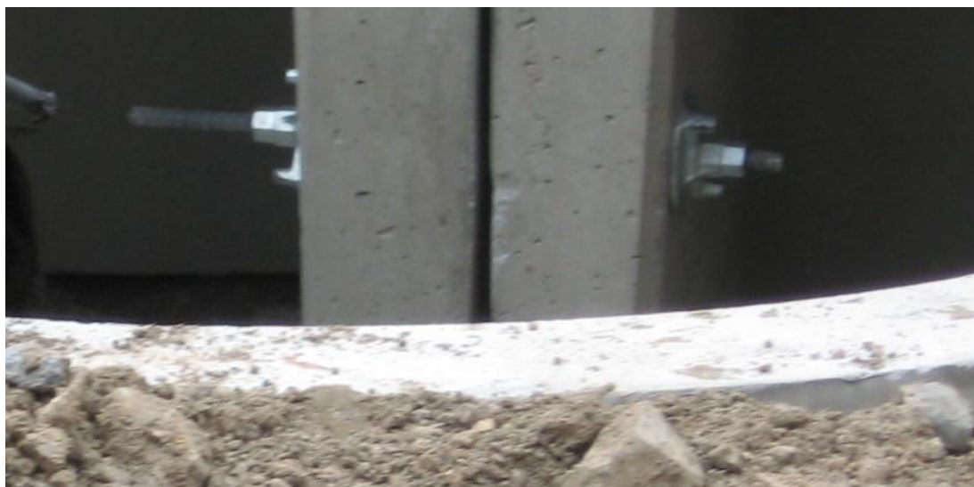
Obrázek 4 Detail spojení Kořenových obrub
