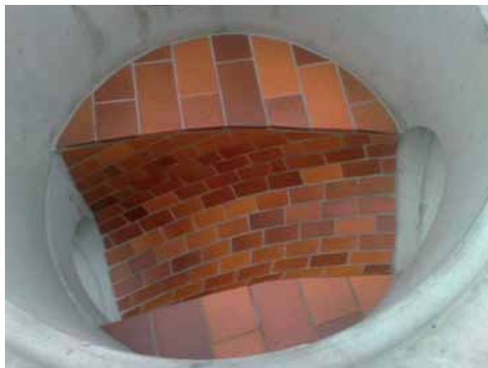
Výstelka kameninovými pásky + skluz + obklad nástupnice.
