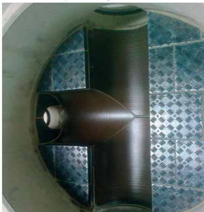
Výstelka čedičem ze žlabů + obklad nástupnice.
