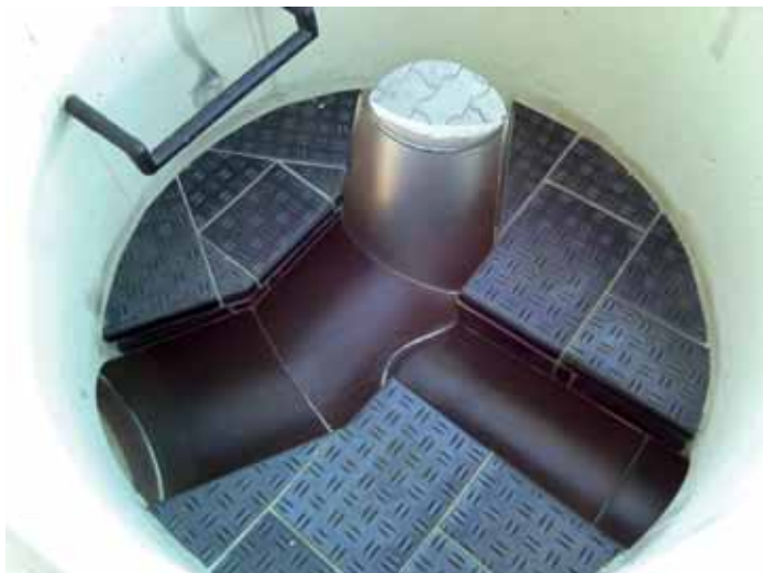
Výstelka čedičem – odpovídá pražským standardům.
