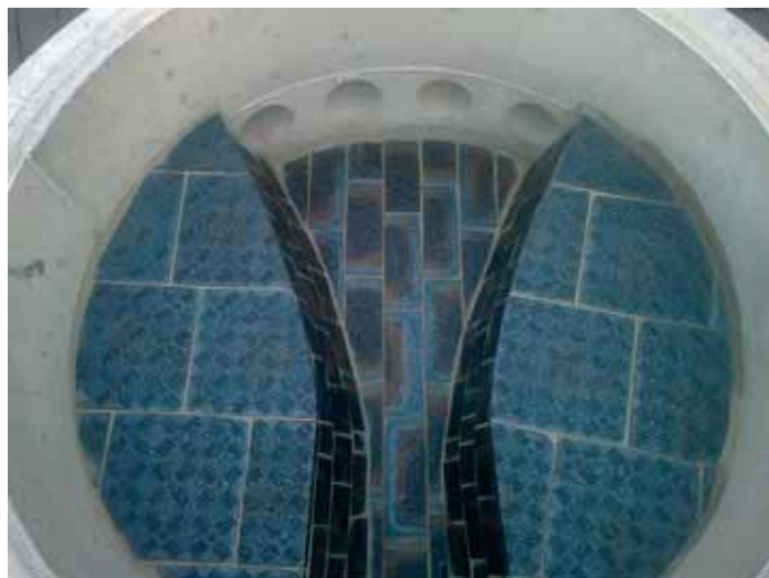
Výstelka čedičovými pásky + obklad nástupnice.
