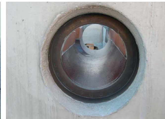
Vstup do šachtového dna pomocí osazení GFK vložky bez těsnění pro potrubí např.: kamenina PUR – zakázková výroba
