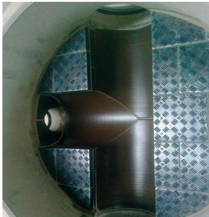
Výstelka čedičem ze žlabů + obklad nástupnice.
