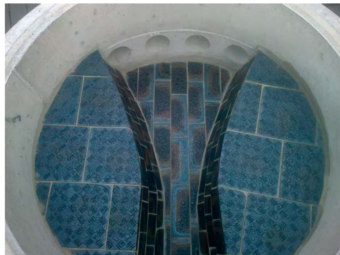
Výstelka čedičovými pásky + obklad nástupnice.
