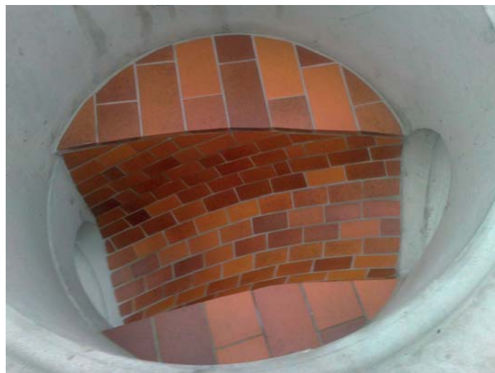
Výstelka kameninovými pásky + skluz + obklad nástupnice.
