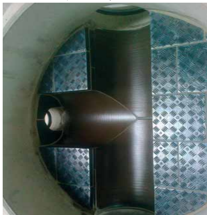
Výstelka čedičem ze žlabů + obklad nástupnice.
