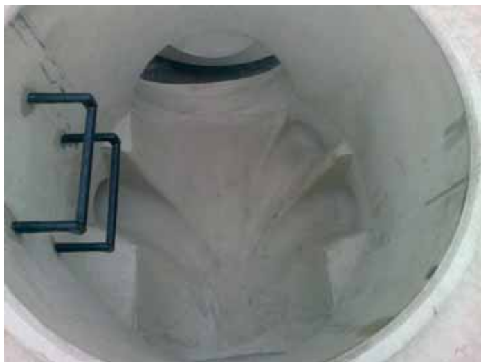
Vstup s vkládaným těsněním.
