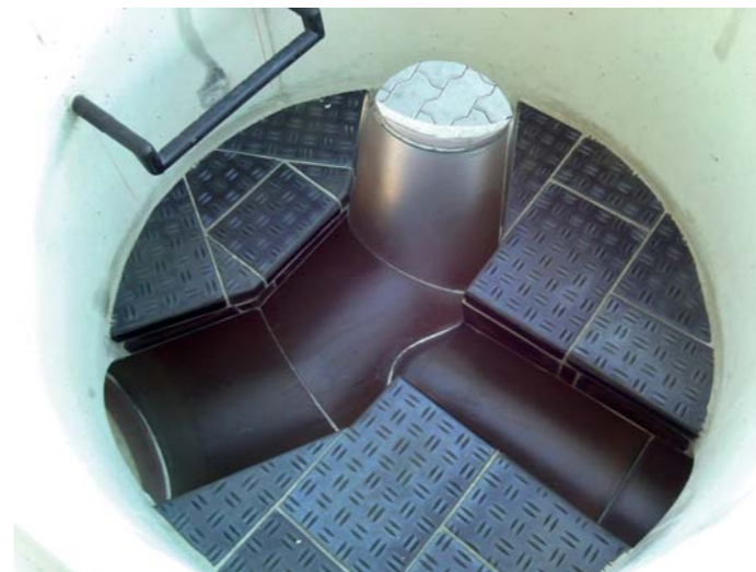
Výstelka čedičem – odpovídá pražským standardům.
