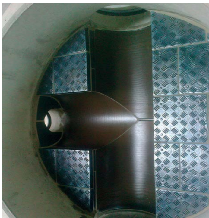
Výstelka čedičem ze žlabů + obklad nástupnice.
