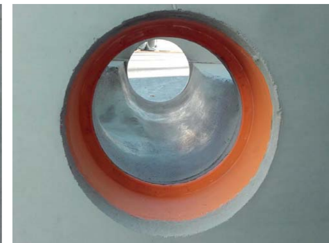
Vstup do šachtového dna pomocí osazení GFK vložky pro potrubí např.: UR2 DIN – zakázková výroba
