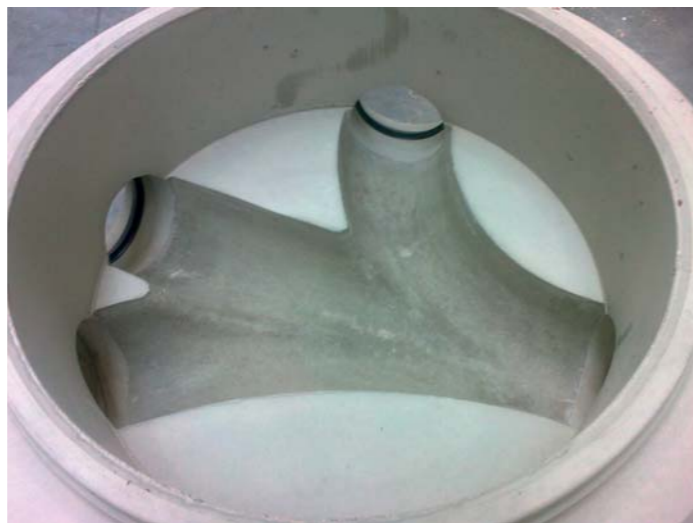
Vstup s vkládaným těsněním.
