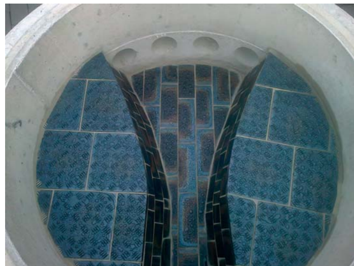
Výstelka čedičovými pásky + obklad nástupnice.
