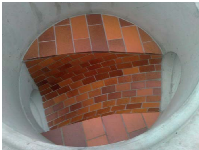
Výstelka kameninovými pásky + skluz + obklad nástupnice.
