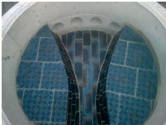
Výstelka čedičovými pásky + obklad nástupnice.
