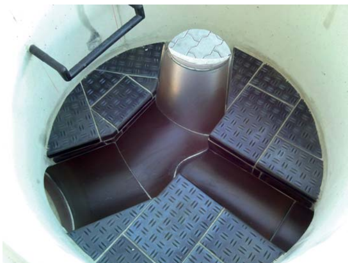
Výstelka čedičem – odpovídá pražským standardům.
