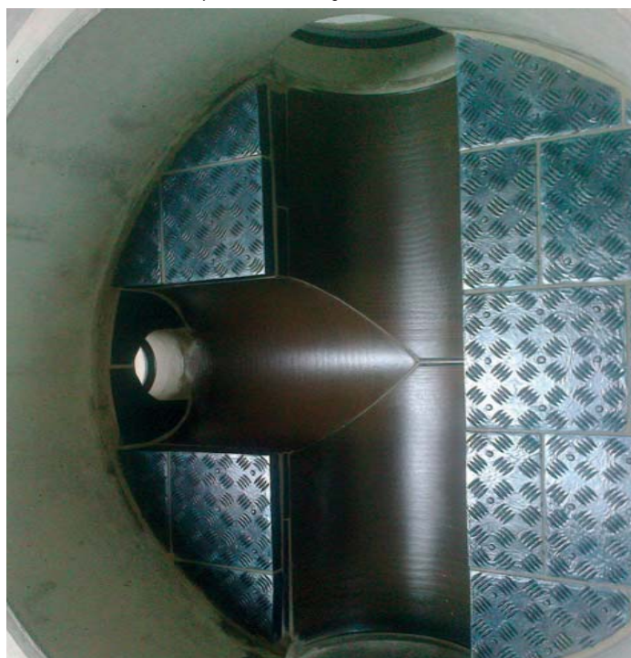
Výstelka čedičem ze žlabů + obklad nástupnice.
