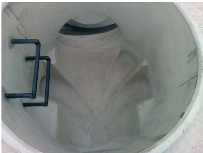
Vstup s vkládaným těsněním.
