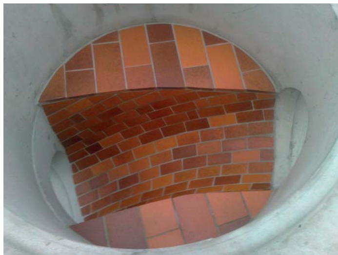
Výstelka kameninovými pásky + skluz + obklad nástupnice.
