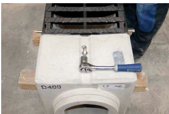
Obr. 15.5 Nasazení mříže a zaražení čepů.
