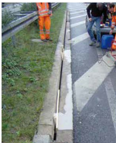
Obr. 14 Příklad opravy štěrbinového žlabu pomocí DENSO TOK®-Crete 45 (v 2.0). Fotografie jsou z provádění opravy pro zajištění funkčnosti a bezpečnosti provozu, bez vyšších požadavků na vzhled opraveného místa.
