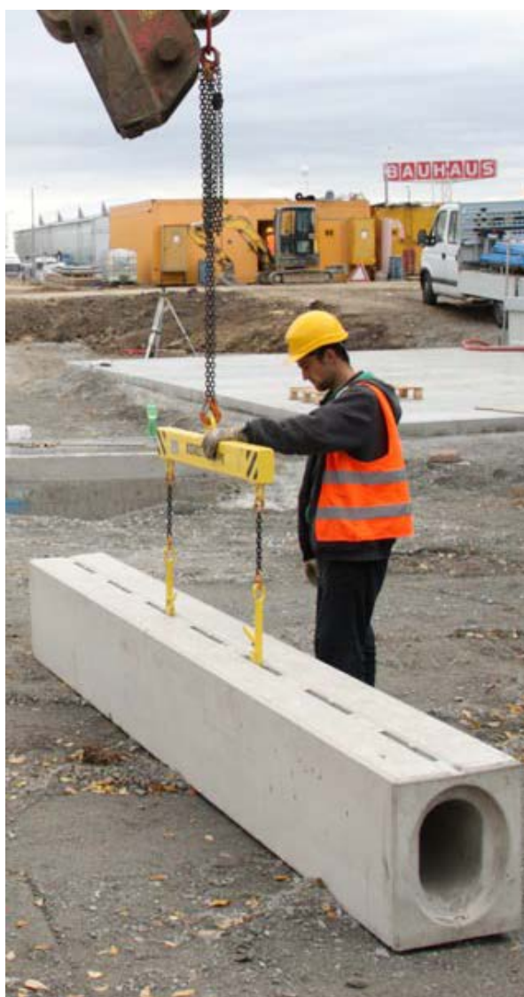
Obr. P1.3 Manipulační přípravek „lopatky“, zavěšený na manipulační technice.
