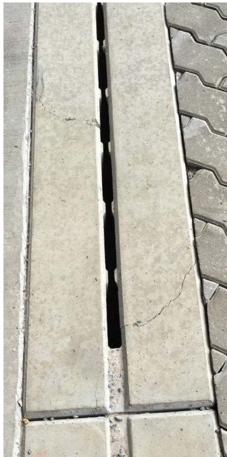
Obr. 13 Příklady vad z nefunkčních dilatací.
