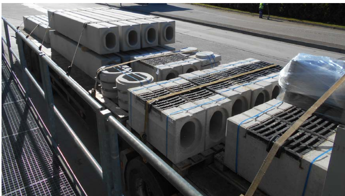
Obr. 1 Příklad dopravy štěrbínových žlabů a jejich zajištění proti posuvu během přepravy – základní díly dlouhé 3995 mm a doplňkový sortiment
