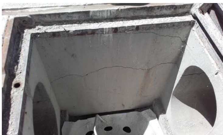
Obr. 13 Příklady vad z nefunkčních dilatací.
