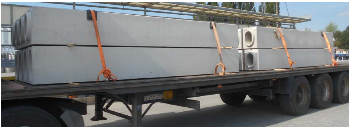
Obr. 2 Příklad dopravy štěrbinových žlabů a jejich zajištění proti posunu během přepravy – základní díly dlouhé 3995 mm.
