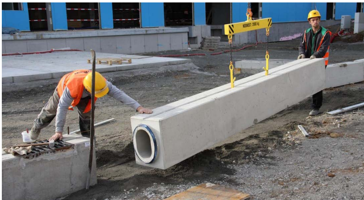
Obr. 10 Fotografie z pokládky štěrbinových žlabů.
