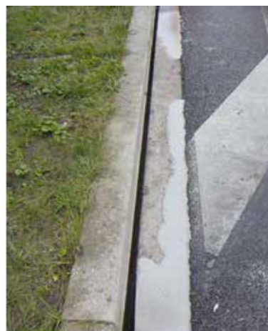
Obr. 14 Příklad opravy štěrbinového žlabu pomocí DENSO TOK®-Crete 45 (v 2.0). Fotografie jsou z provádění opravy pro zajištění funkčnosti a bezpečnosti provozu, bez vyšších požadavků na vzhled opraveného místa.
