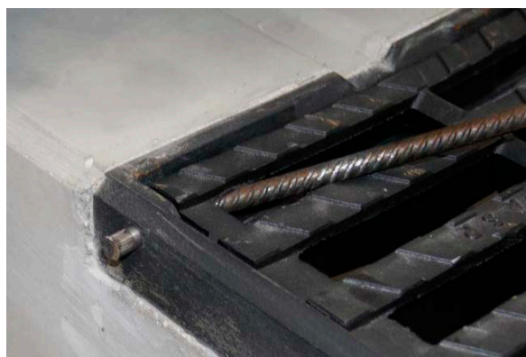
Obr. 15.2 Vyklepnutí čepů – zevnitř.
