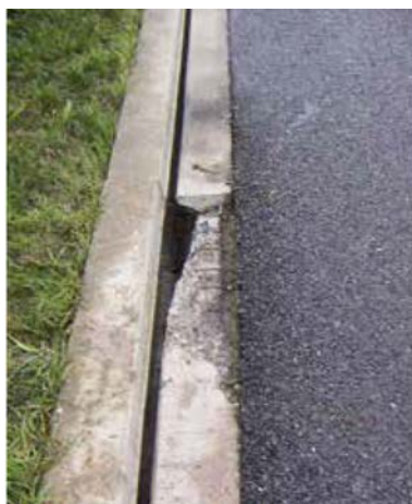
Obr. 14 Příklad opravy štěrbinového žlabu pomocí DENSO TOK®-Crete 45 (v 2.0). Fotografie jsou z provádění opravy pro zajištění funkčnosti a bezpečnosti provozu, bez vyšších požadavků na vzhled opraveného místa.
