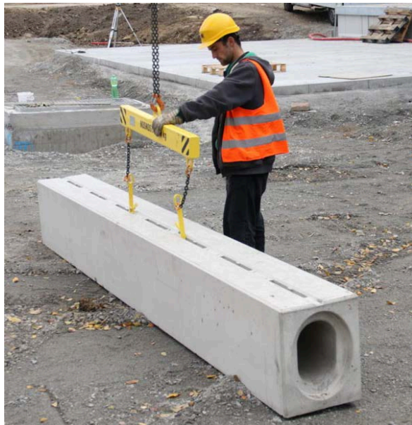
Obr. 5 Příklad manipulace štěrbinových žlabů na stavbě.
