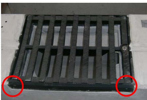
Obr. 15.6 Umístění otvorů pro čepy v rámu.
