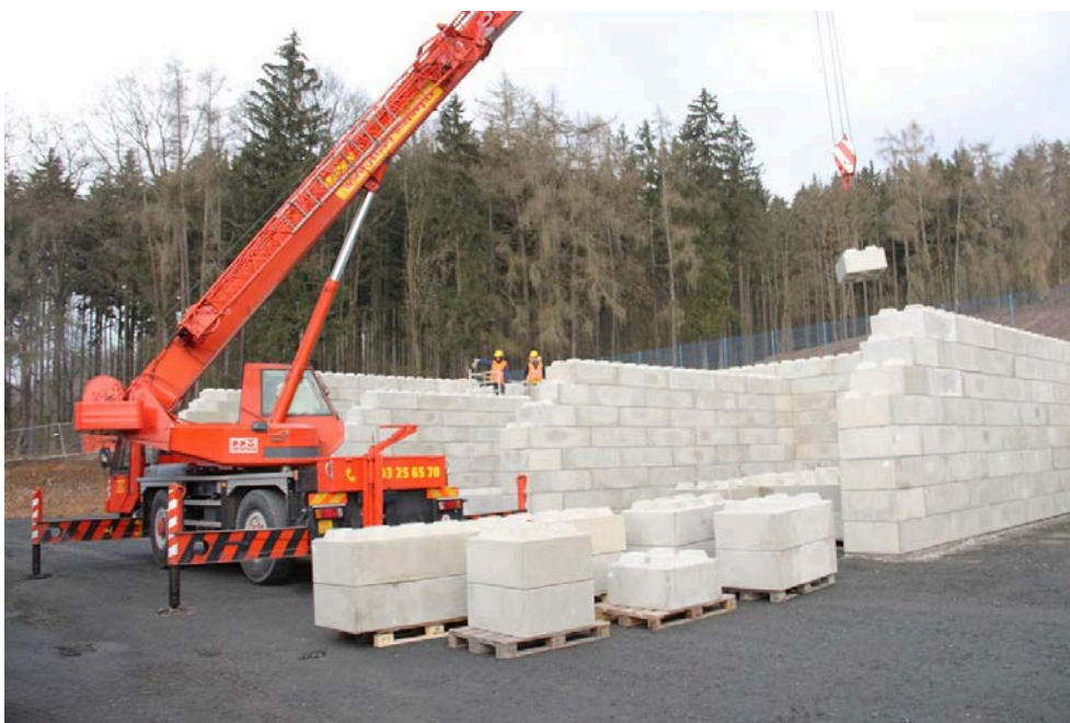
Obrázek 3 Příklad manipulace při montáži
