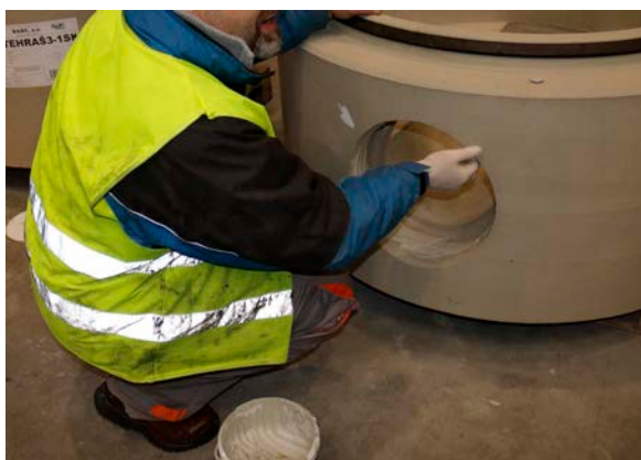
Obr. 10 Příklad aplikace kluzného prostředku na tvarovaný spoj přípojného potrubí
