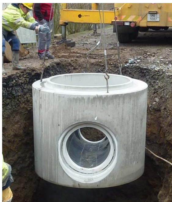
Obr. 4 Příklad manipulace šachtového dna – zabudované manipulační prvky Rd.
