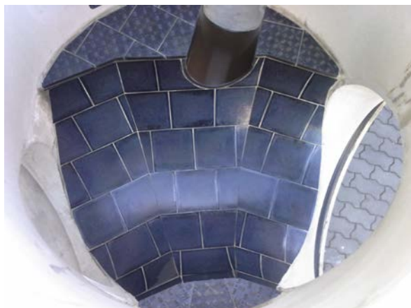
Obrázek P1.13 Výstelka a nástupnice čedičem
