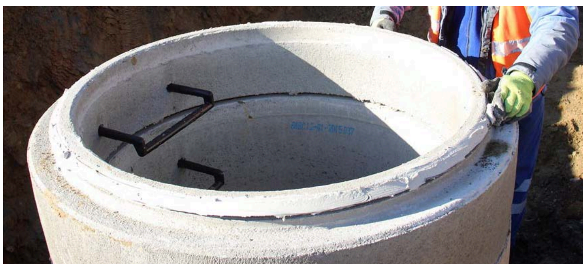
Obr. 9 Příklad aplikace kluzného prostředku na těsnění, před osazením dalšího dílce sestavy.
