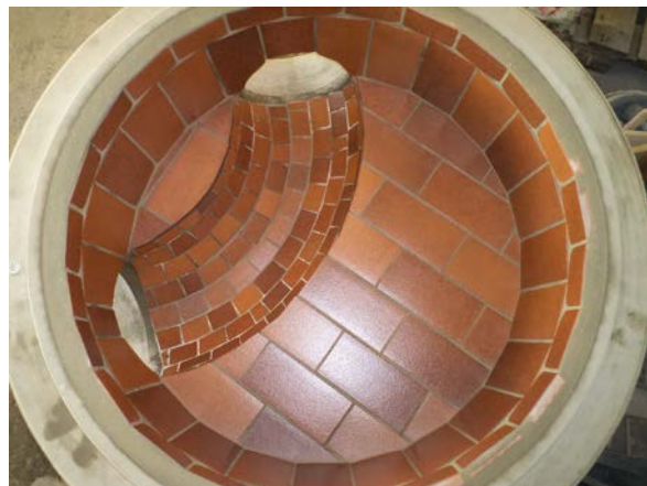
Obrázek P1.16 Výstelka, nástupnice a obklad kameninou
