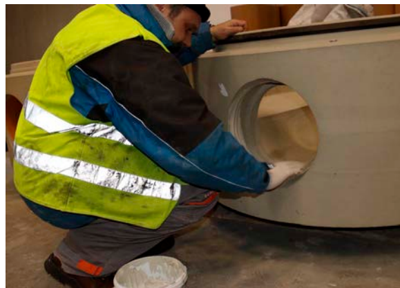
Obr. 11 Příklad aplikace kluzného prostředku na tvarovaný spoj přípojného potrubí
