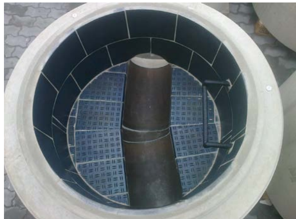
Obrázek P1.14 Výstelka, nástupnice a obklad čedičem
