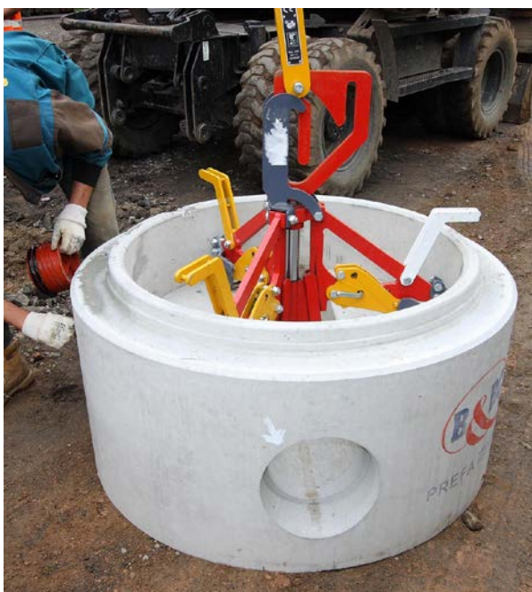
Obr. 3 Příklad manipulace prvků – kleště SchachtFIX.
