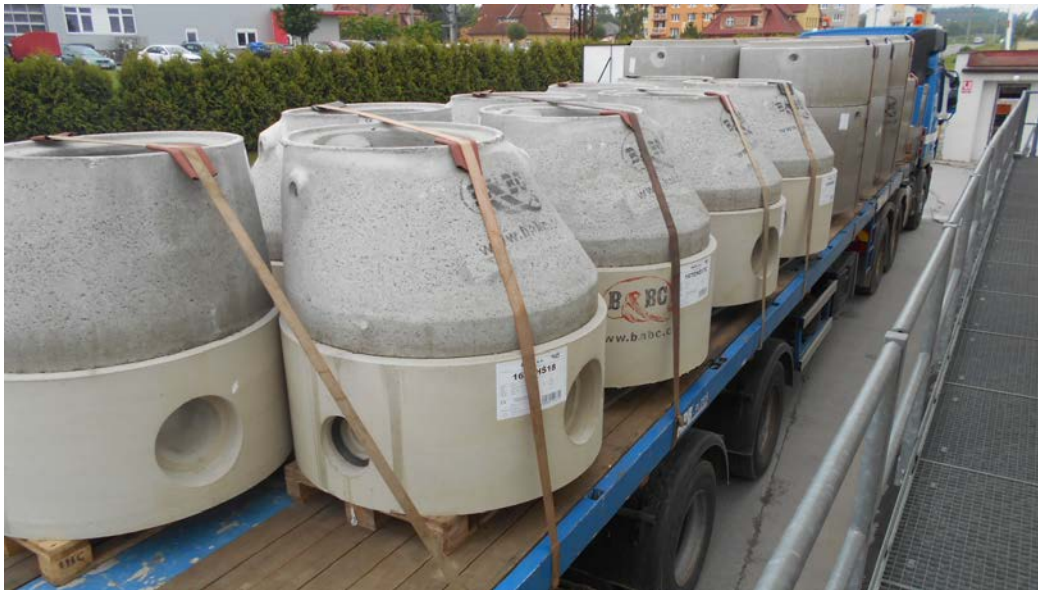
Obr. 2 Příklad dopravy prvků a jejich zajištění při dopravě
