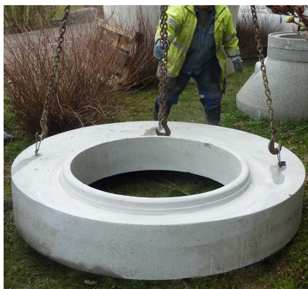
Obr. 5 Příklad manipulace prvky – zabudované manipulační prvky Rd.
