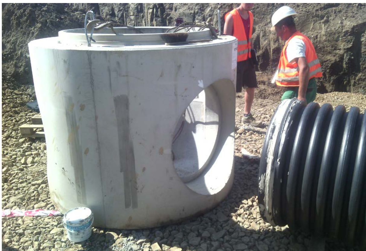
Obr. 12 Příklad přípravy šachtového dna a přípojného potrubí před zahájením spojování.
