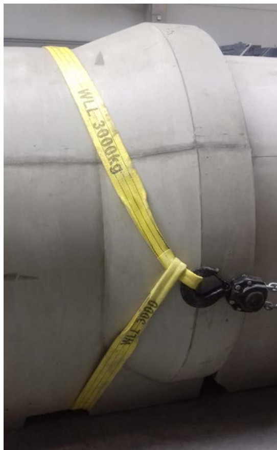
Obr. P2.4 - Zaháknutí háků ráčnových řetězových zvedáků (nosnost každého 6t) do vázacího textilního pásu
