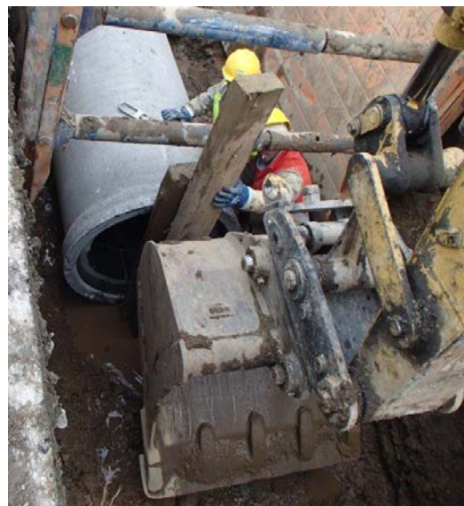
Obr. 11 Příklad spojování trub pomocí staveništní mechanizace
