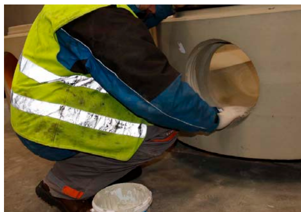
Obr. 14 Příklad aplikace kluzného prostředku na tvarovaný spoj přípojných potrubí
