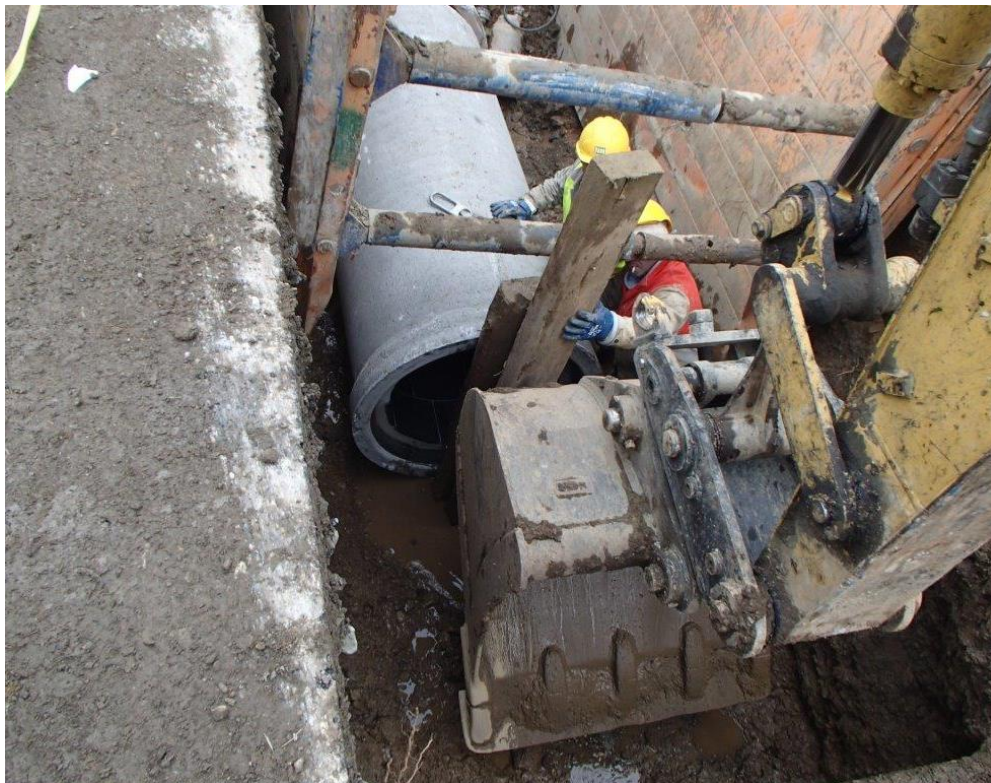
Obr. P3.1 – Na hrdlo trouby se přiloží dřevěné trámky (1 či 2 dle jejich rozměrů), v horizontální či vertikální poloze, dle prostorových možností stavby.
