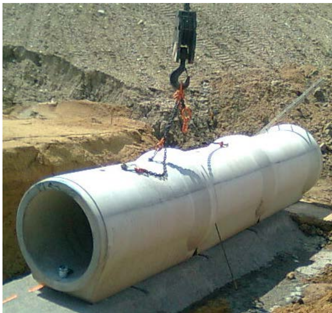
Obr. 6 Příklad spojení trub řetězovým ukladačem
