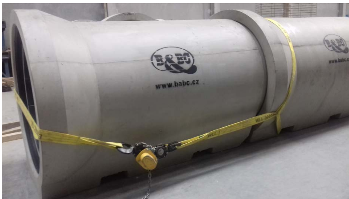
Obr. P2.7 - Stažení trub
