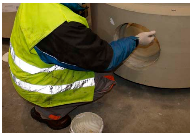
Obr. 13 Příklad aplikace kluzného prostředku na tvarovaný spoj přípojných potrubí
