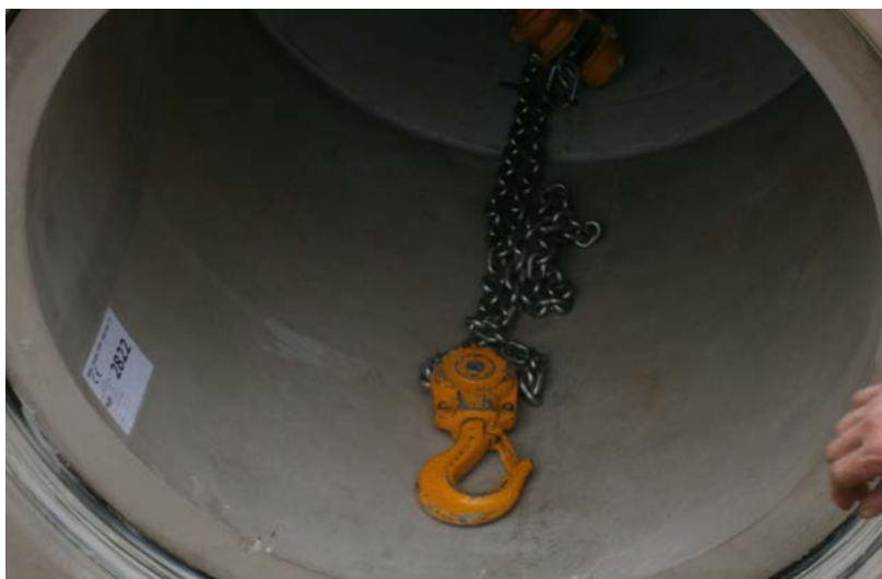
Obr. 8 Příklad protažení stahovacího prostředku vnitřkem trouby
