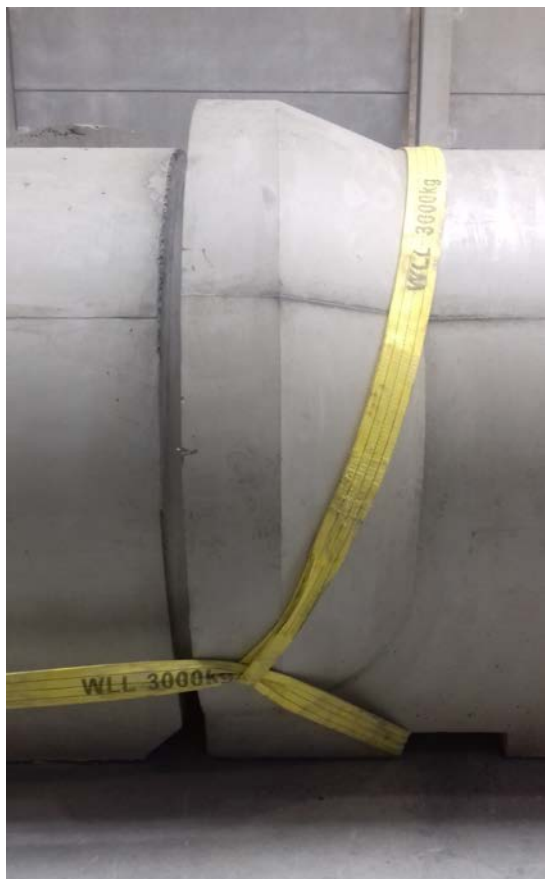
Obr. P2.3 - Provlčení vázacího textilního pásu 3t délka 3 m pod patkou již usazené trouby, skrz vybrání v patce trouby
