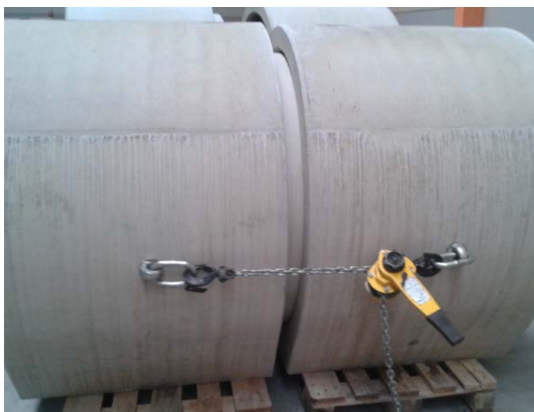
Obr. 9 Příklad stahování trub TZPP
