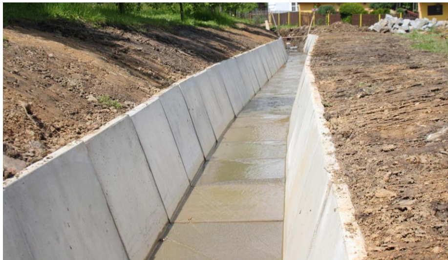
Obrázek 5 Příklad realizace odvodňovacích žlabů 100-127
