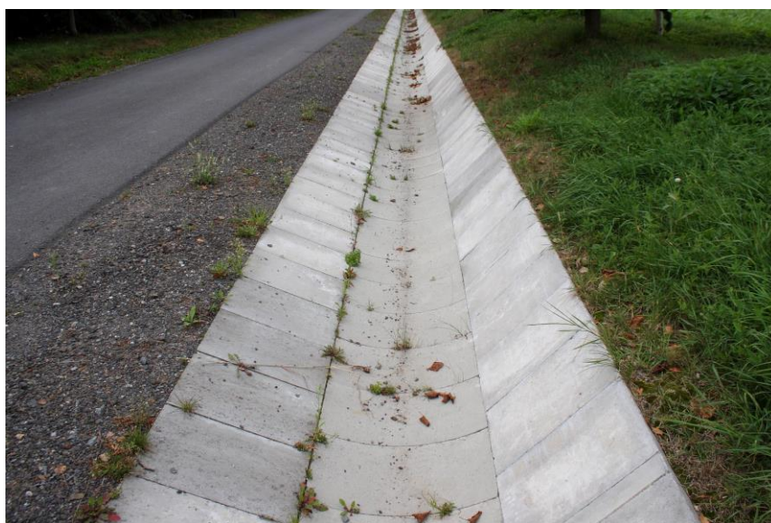
Obrázek 4 Příklad realizace odvodňovacích žlabů a příložené desky
