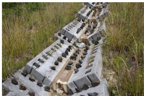
Obrázek 4 Příklad realizace odvodňovací linie v terénu
