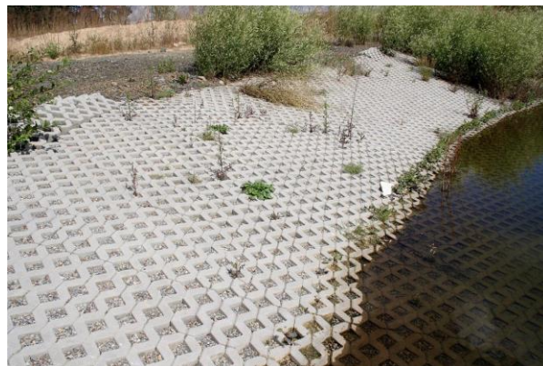
Obrázek 6 Příklad realizace zpevnění svahu u vodní nádrže
