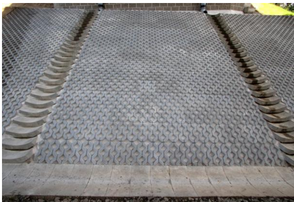
Obrázek 5 Příklad realizace zpevnění svahu pod mostním objektem
