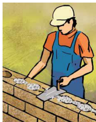
Obr. 8 Probetonování
