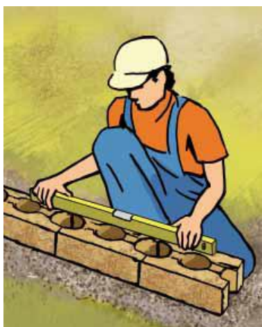
Obr. 6 Vyrovnání první vrstvy
