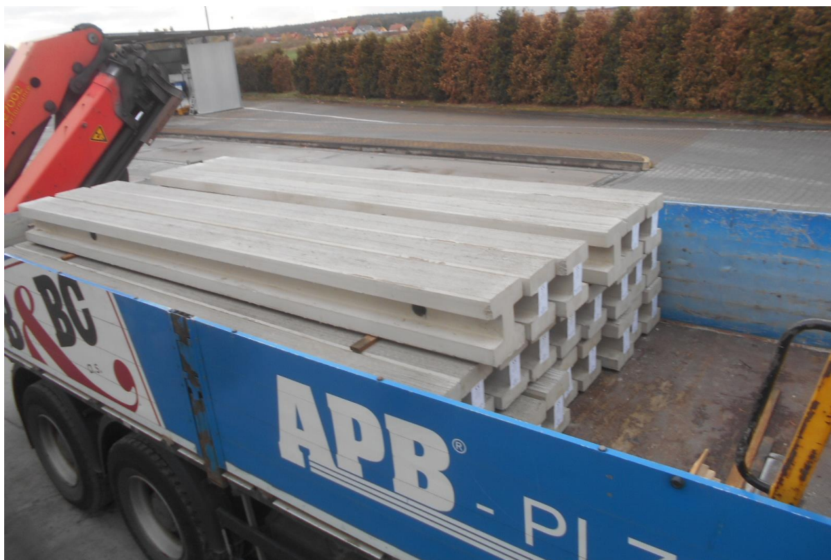
Obrázek 1 Příklad dopravy sloupků (před zajištěním proti posunu).
