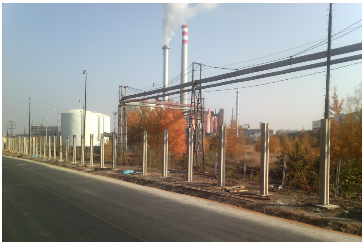
Obrázek 7 Příklad provedení osazení sloupků, před vložením panelů.
