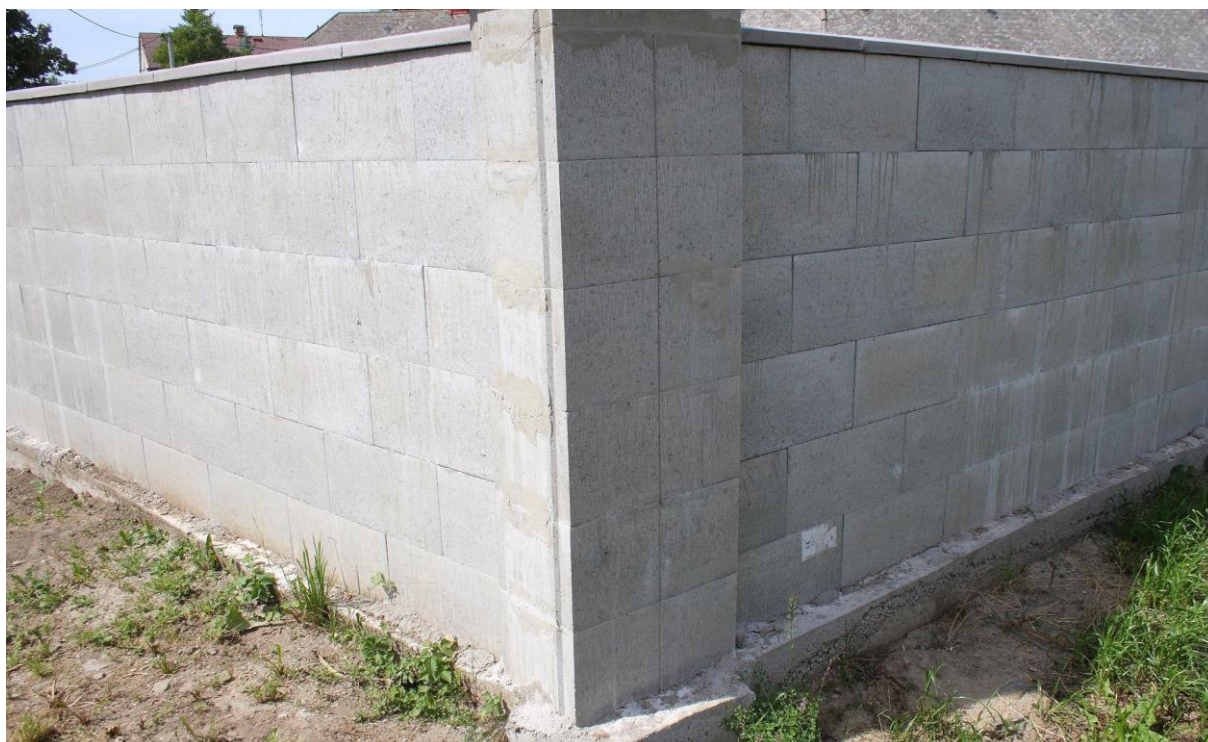
Obrázek 1 Příklad realizace plotu z tvárnice ZBT
