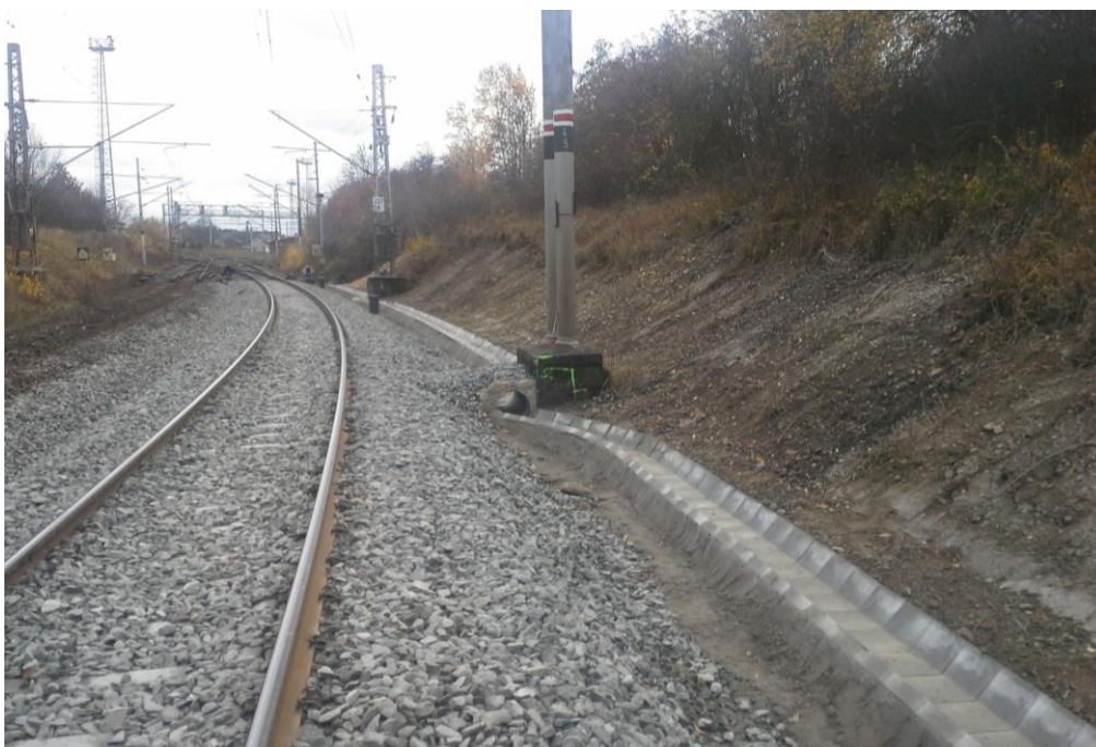
Obrázek 2 Příklad realizace odvodňovacích žlabů
