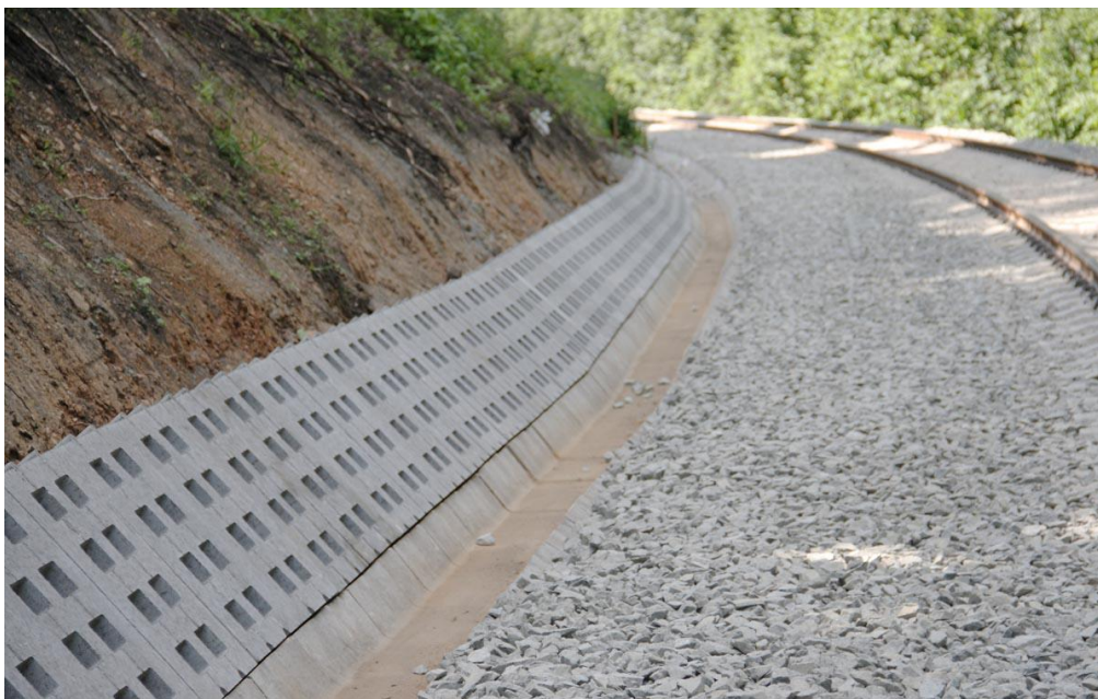
Obrázek 3 Příklad realizace odvodňovacích žlabů
