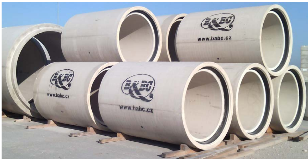
Obr. 2 Příklad skladování trub
