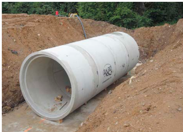
Obr. 5 Příklad zajištění trub pomocí dřevěných klínů, celkový pohled
