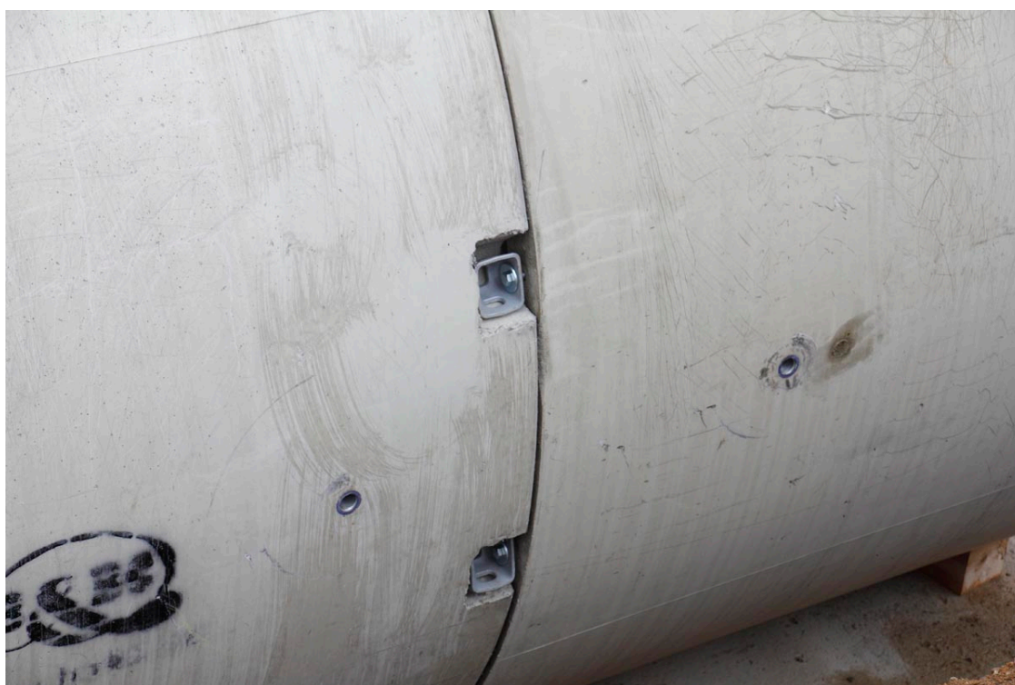
Obr. 17 Umístění dvojice spojovacích zámků z vnější strany trouby. Z druhé strany trouby je symetricky umístěna druhá dvojice spojovacích zámků – celkem 4 na jeden spoj.
