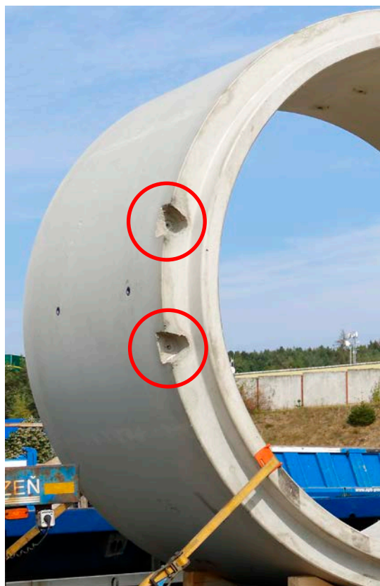
Obr. 14 Detail přípravy na spojovací zámekek na troubě.
