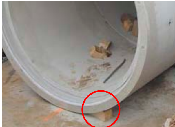
Obr. 6 Příklad zajištění trub pomocí dřevěných klínů, detail
