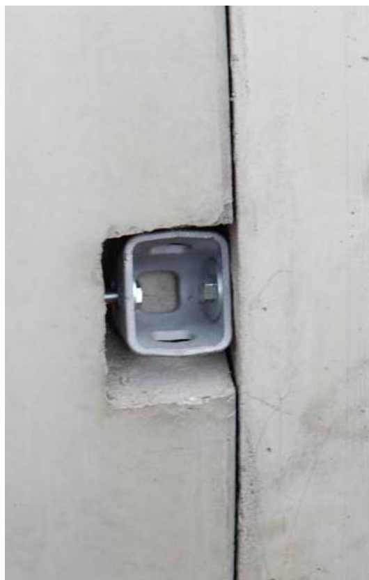
Obr. 15 Osazený spojovací zámekek
