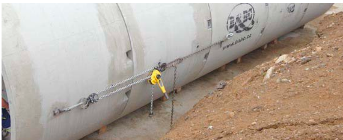
Obr. 9 Příklad stahování trub – ob troubu, aby nedošlo k vytažení prostřední trouby. Vlevo zdvihák pro vyhnutý lanový závěs, vpravo závěsný šroub s neotočným okem.
