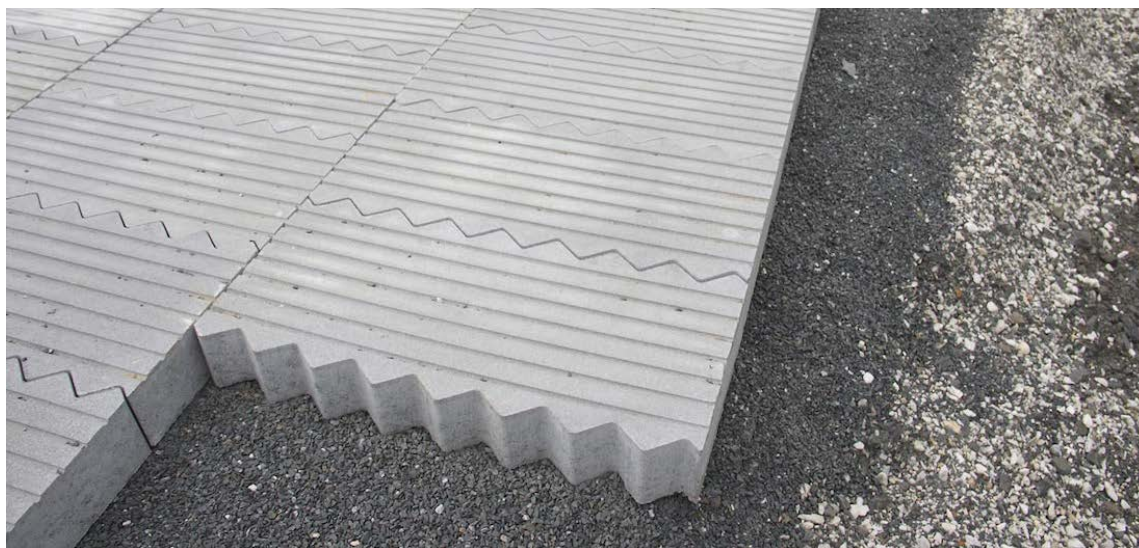
Obr. 2 Příklad uložení dlažby na ložnou vrstvu.
