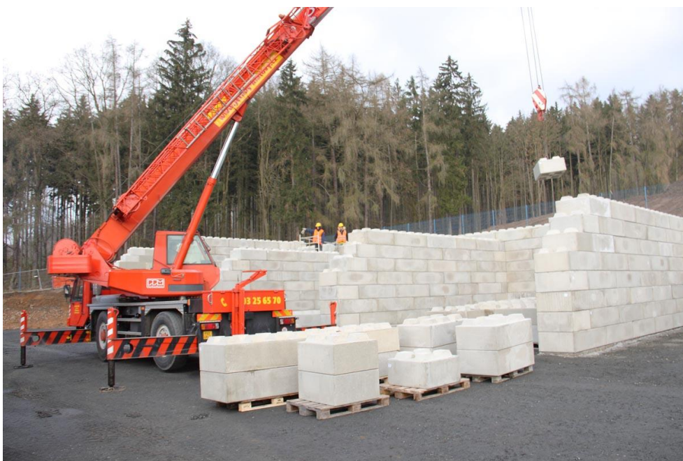
Obrázek 3 Příklad manipulace při montáži
