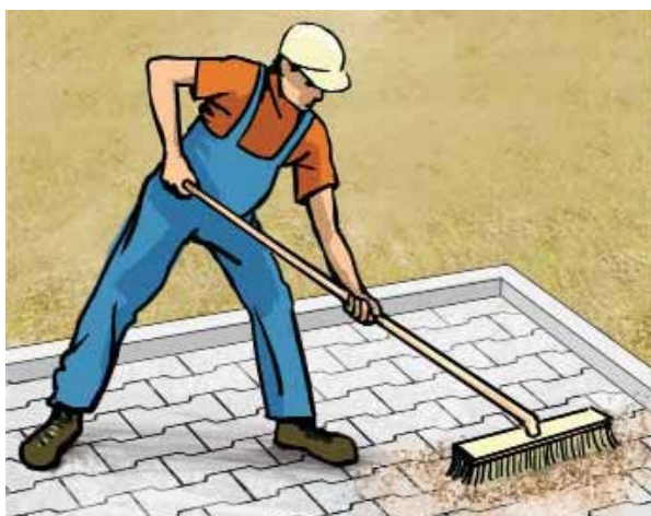
Obr. 6 Zapískování.
