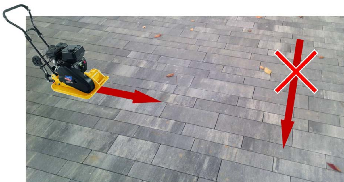
Obr. 8 Příklad hutnění dlažby B&BC Sexta.
