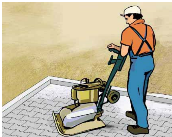
Obr. 7 Strojní hutnění dlažby.
