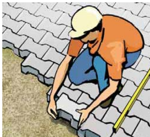
Obr. 5 Pokládání dlažby.
