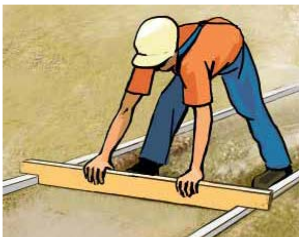
Obr. 4 Srovnání ložné vrstvy latí.
