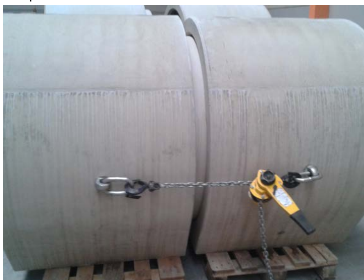
Obr. 9 Příklad stahování trub TZPP
