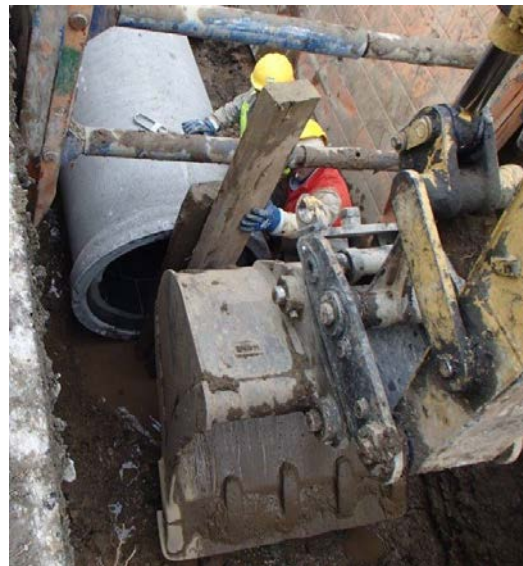
Obr. 11 Příklad spojování trub pomocí staveništní mechanizace
