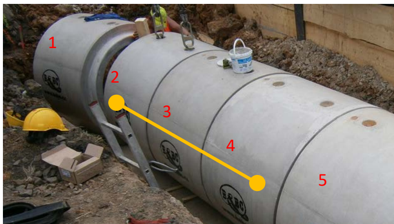
Obrázek P2.3 - Příklad sesazování trub ob troubu. Předejte se tím riziku vytažení poslední osazené trouby.
