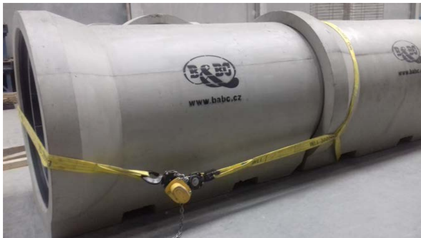
Obr. 10 Příklad spojování trub pomocí lanového textilního pásu a ráčnového stahováku
