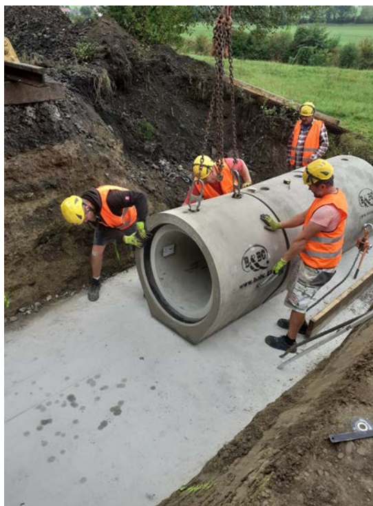
Obr. 3 Příklad manipulace trouby přímé patkové.
