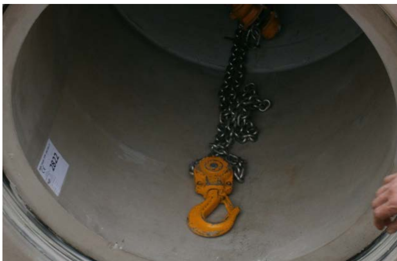
Obr. 8 Příklad protažení stahovacího prostředku vnitřkem trouby
