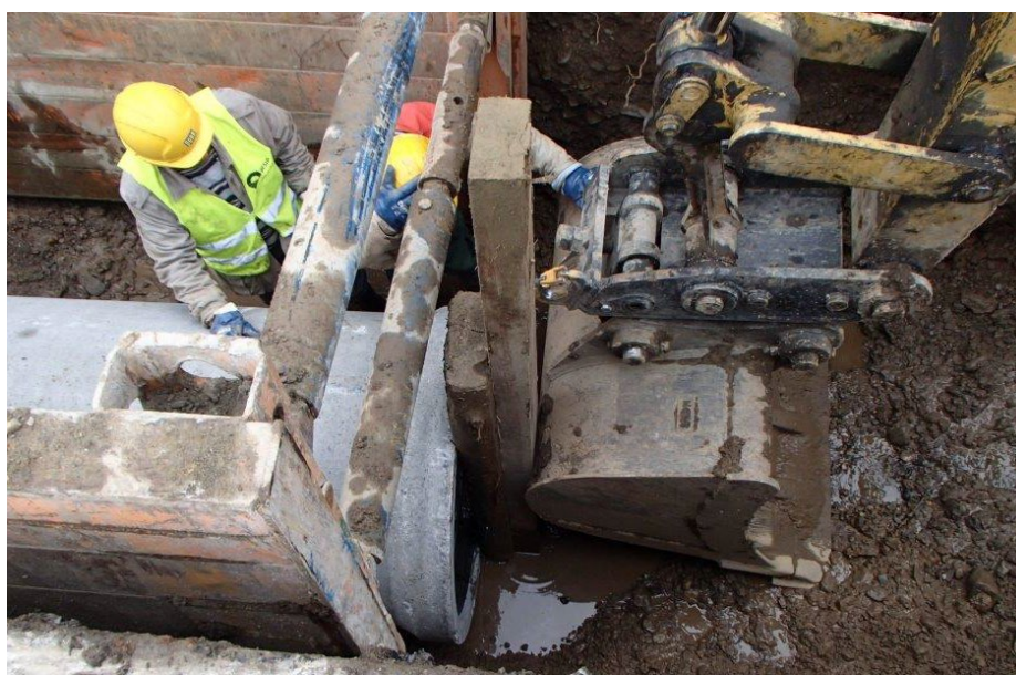
Obr. P3.2 – Na dřevěný trámek se opře rameno staveništní mechanizace, např. bagru, tak aby nedošlo ještě k zatlačování a zároveň aby trámky byly zajištěny před pádem.
