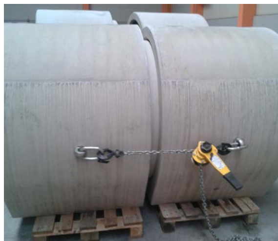
Obrázek P2.2 - Příklad stahování trub za boční kotevní prvky Rd 30.
