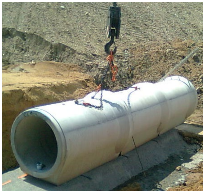
Obr. 6 Příklad spojení trub řetězovým ukladačem
