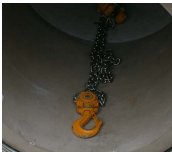
Obrázek P2.1 - Příklad protažení stahovacího prostředku vnitřkem trouby.
