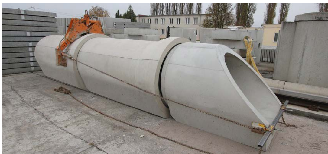
Obr. 7 Princip trubního stahovače
