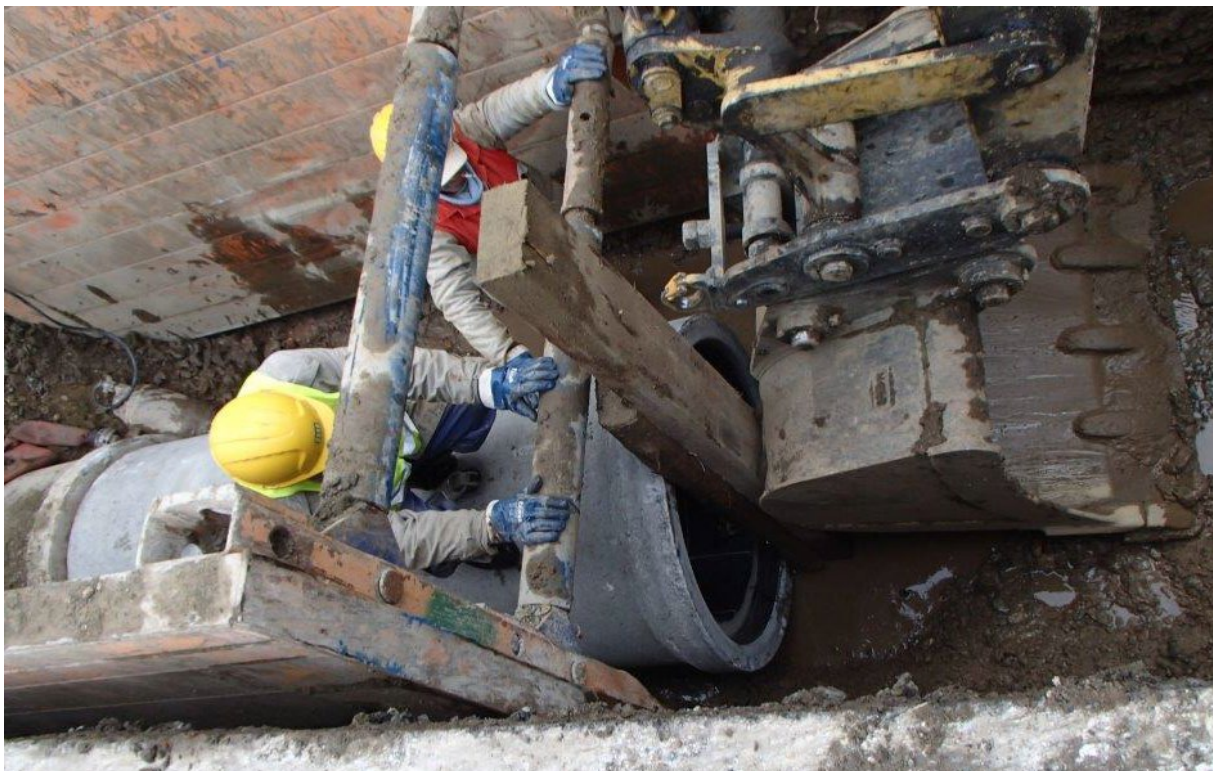
Obr. P3.3 – Na dřevěný trámek se vyvine tlak stavební mechanizací, např. bagr, tak aby došlo k zatlačení na troubu v její podélné ose
